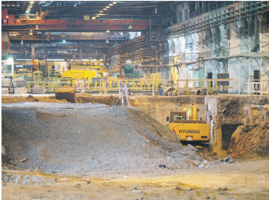
△ На площадке будущего стана обустраивают фундаменты © ДМИТРИЙ БОРОДАЙ
